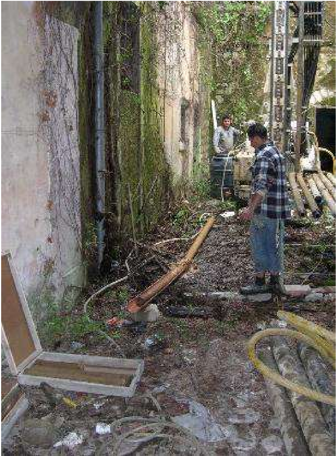
SONDAGGIO S12 PALAZZO CAPORASO (CAROTAGGIO CONTINUO)
