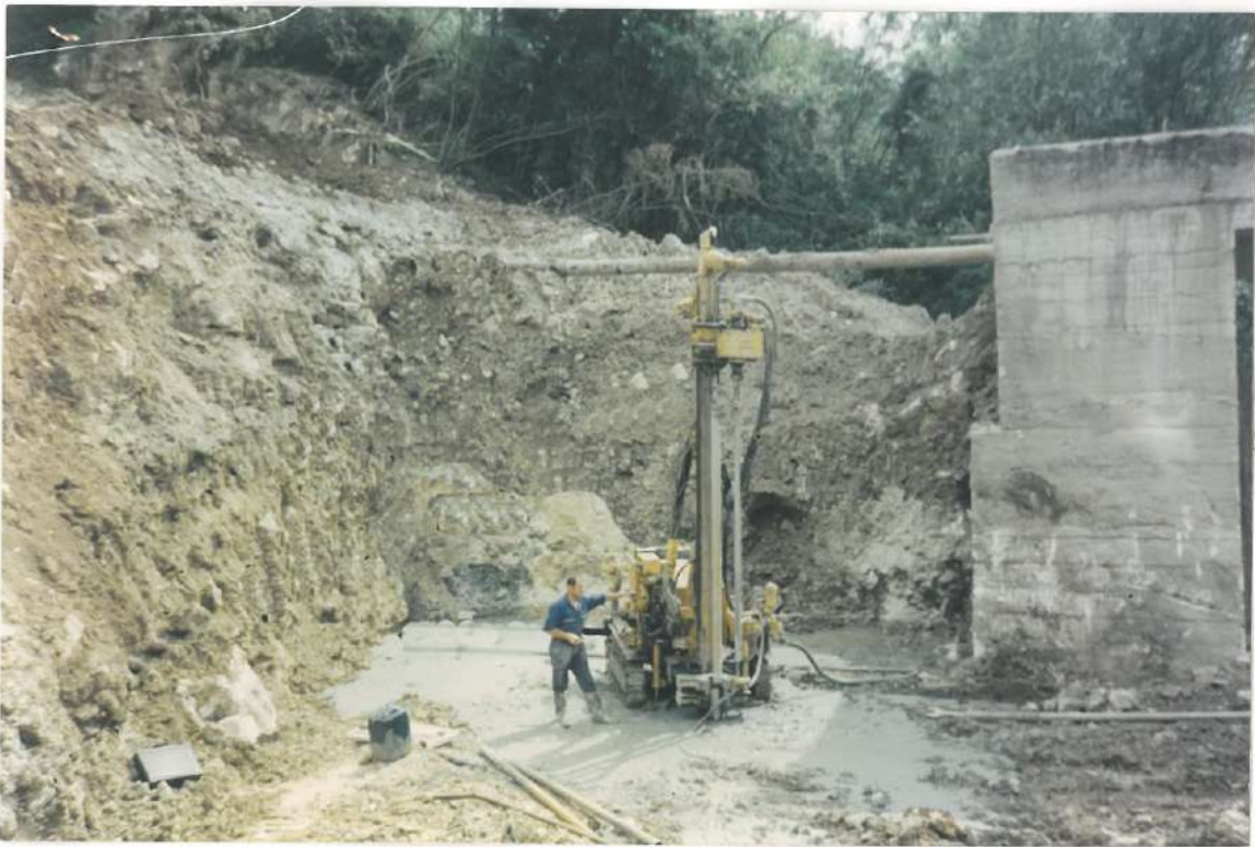
Sondaggio S 23 postazione
