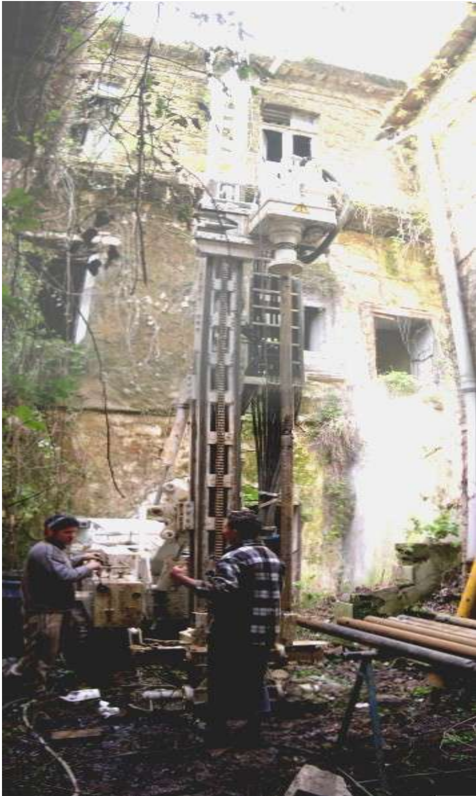
SONDAGGIO S12 POSTAZIONE (INTERNOPALAZZO CAPORASO)
