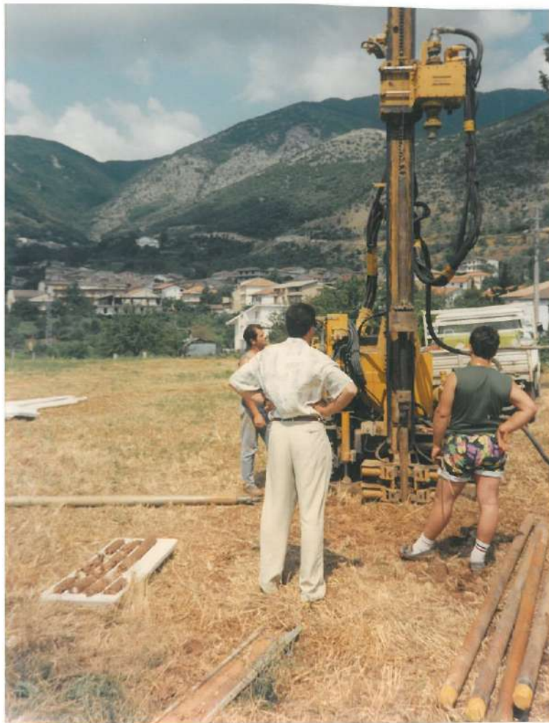
SONDAGGIO S3 POSTAZIONE
