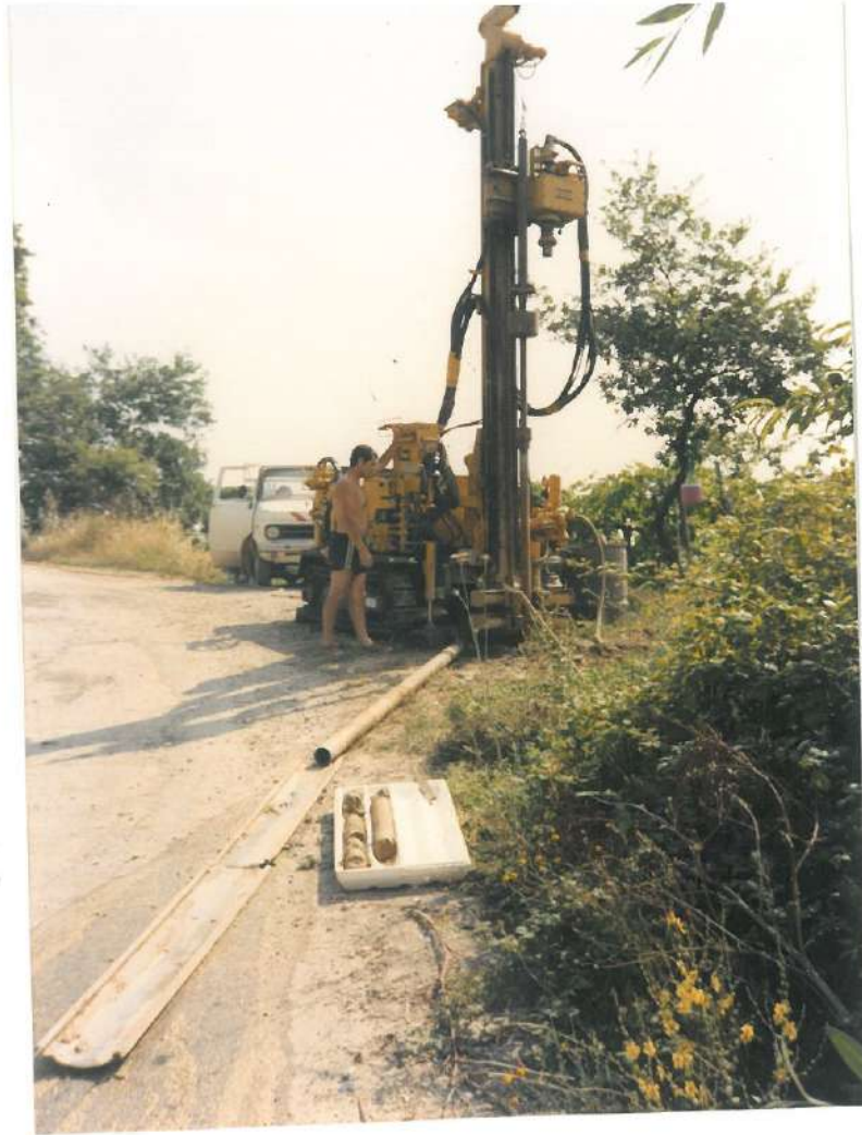
Sondaggio S 7 postazione
