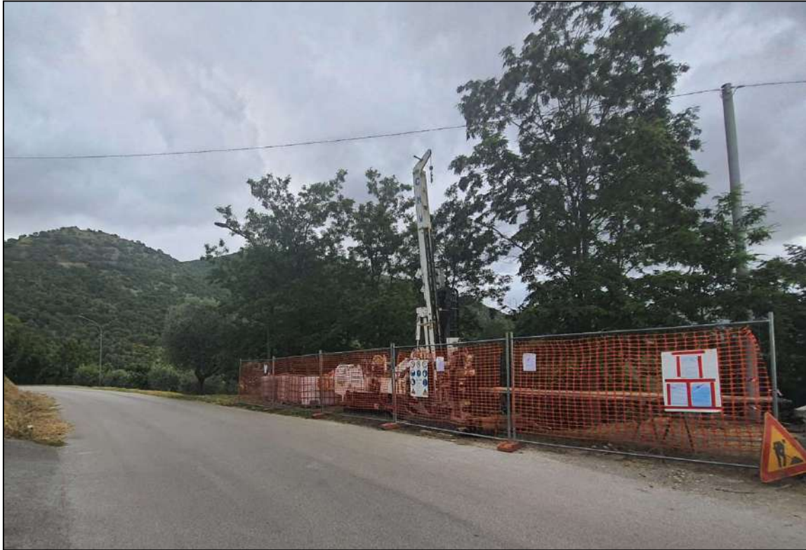
Postazione sondaggio S30
