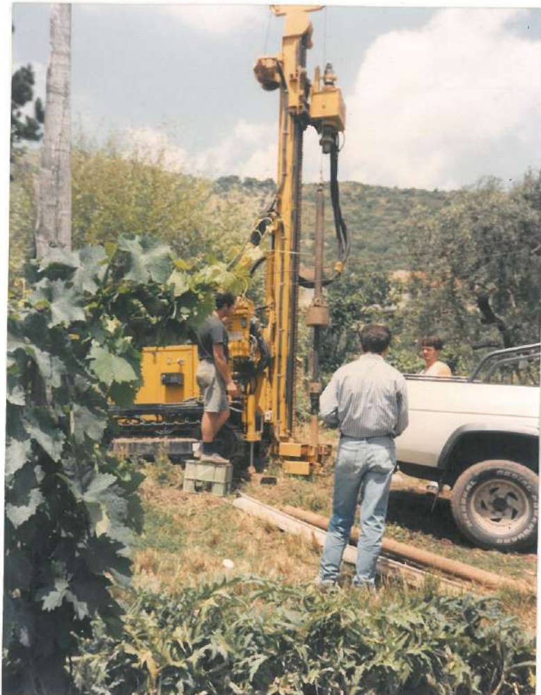
SONDAGGIO S2 POSTAZIONE
