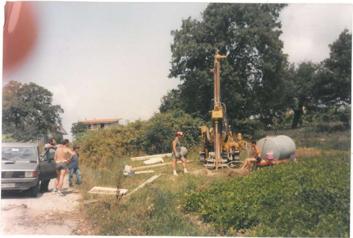
Sondaggio S 8 postazione
