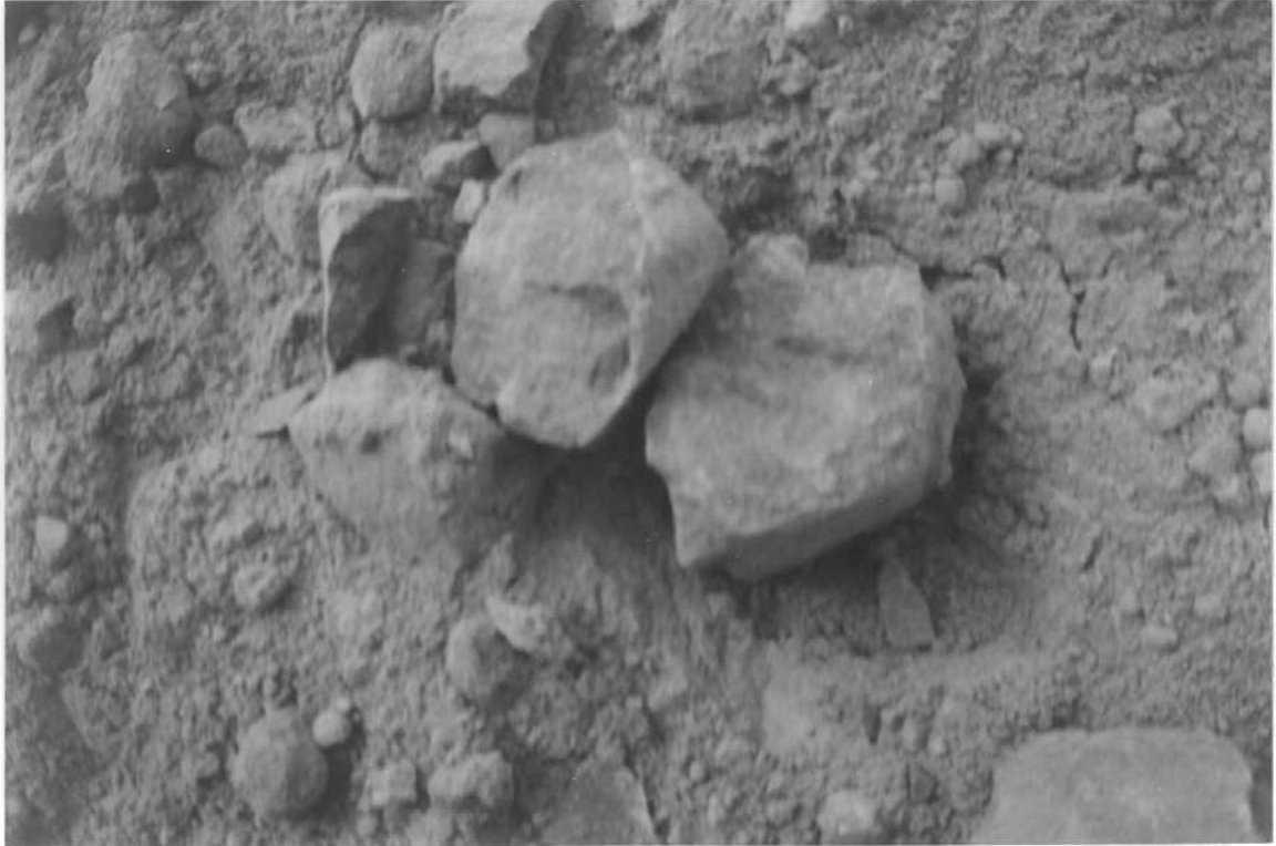
SONDAGGIO S 23 ( particolare carotaggio)
