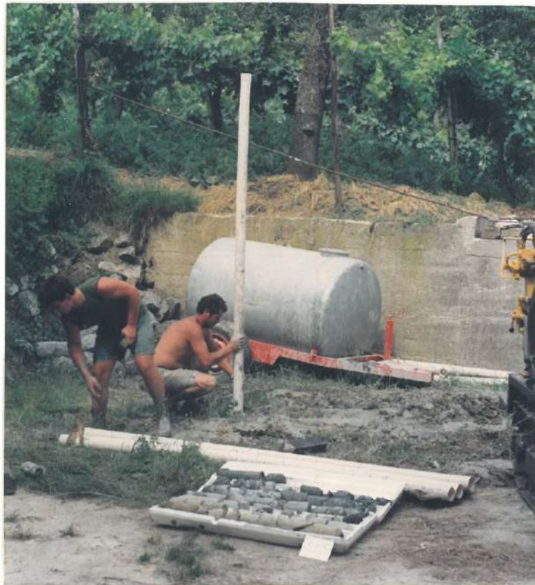
SONDAGGIO S10 POSTAZIONE
