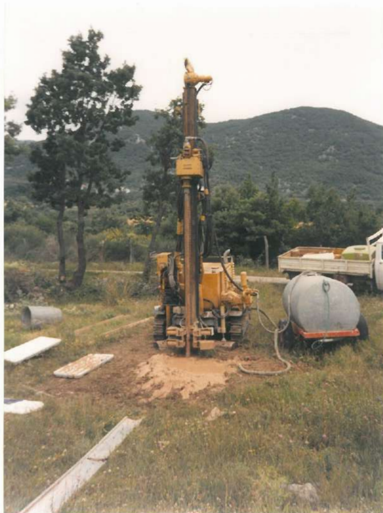
Sondaggio S 9 postazione
