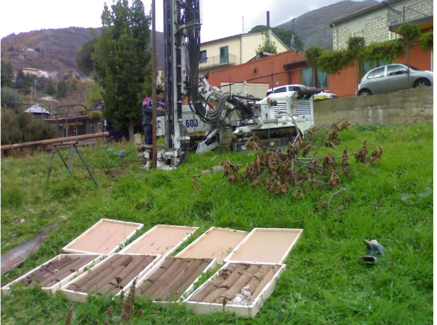
SONDAGGIO S 15 POSTAZIONE
