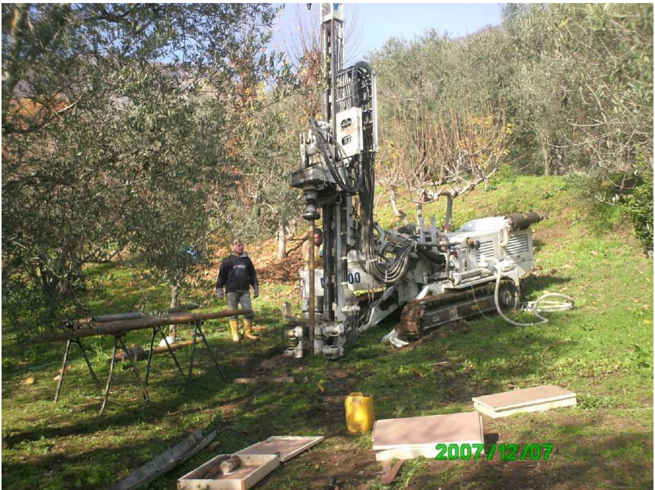
SONDAGGIO S 13 POSTAZIONE
