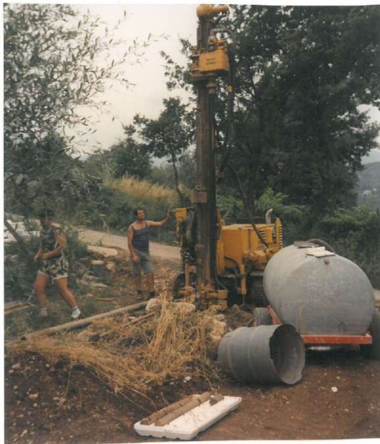
Sondaggio S 6 postazione
