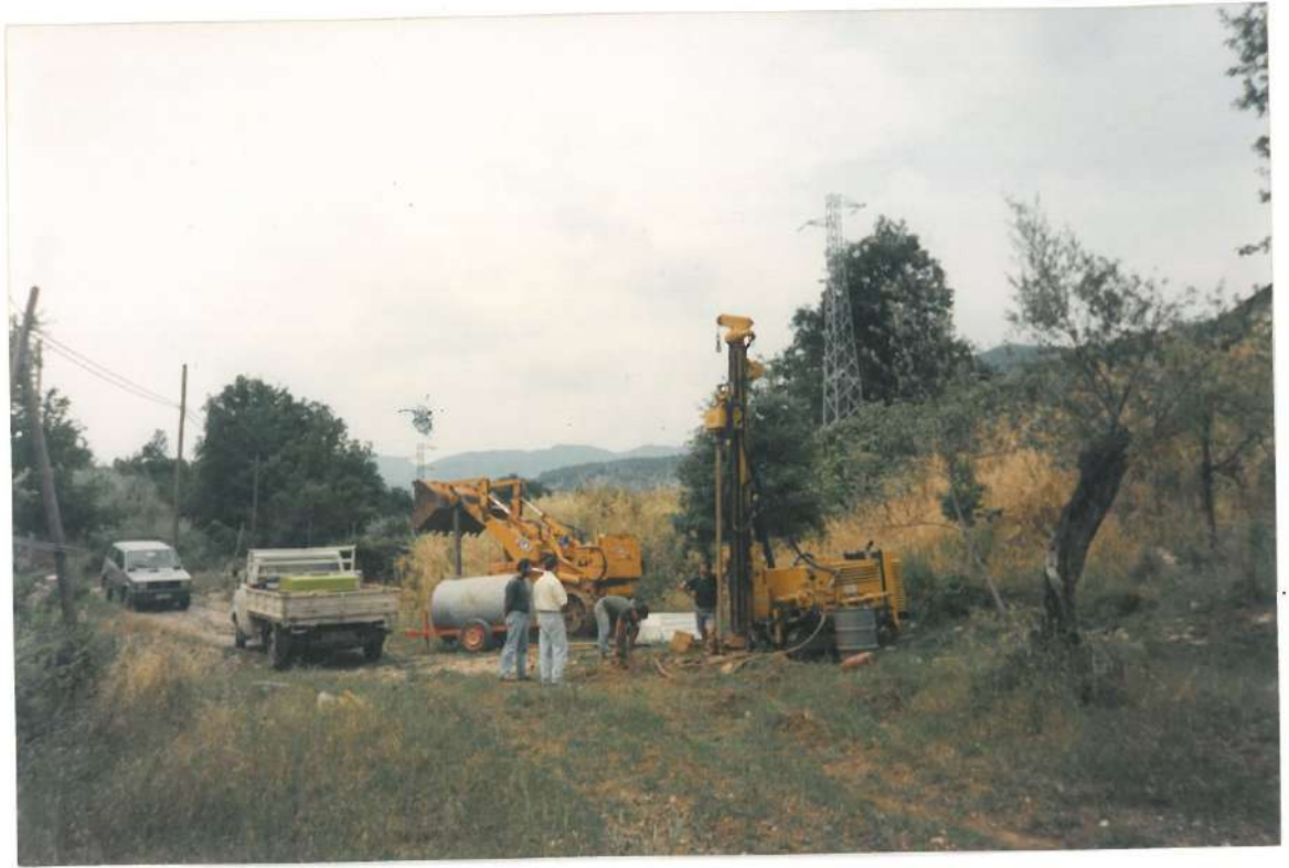
SONDAGGIO S4 POSTAZIONE
