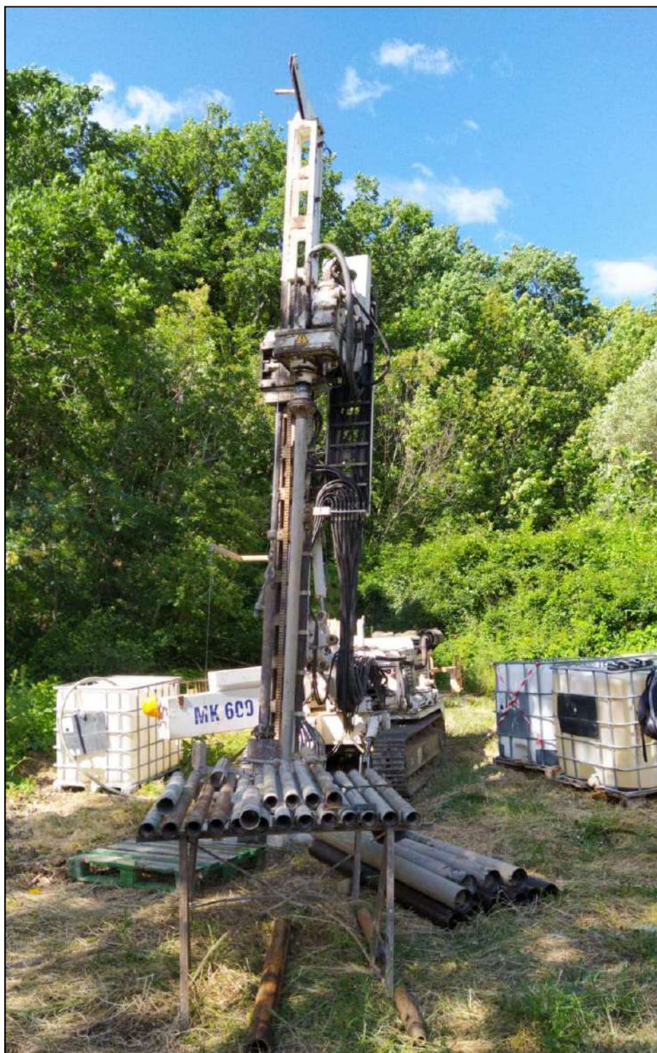
Postazione sondaggio S29
